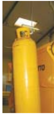
Élévation des bouteilles de gaz
