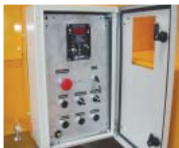
Contrôle électrique des commandes
